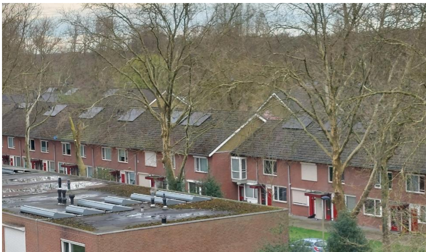
Zonnepanelen op de daken in de straat Houtsdonk
